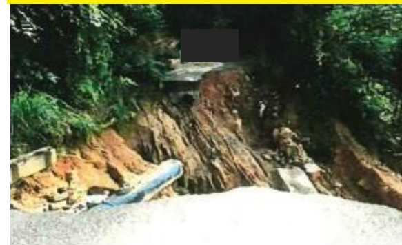
送水管破損
