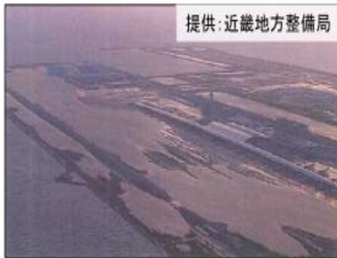
関西空港 空港島（1期島）の冠水の様子
