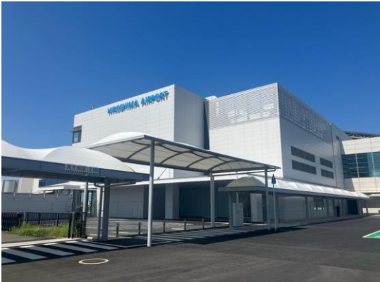
東側増築工事
