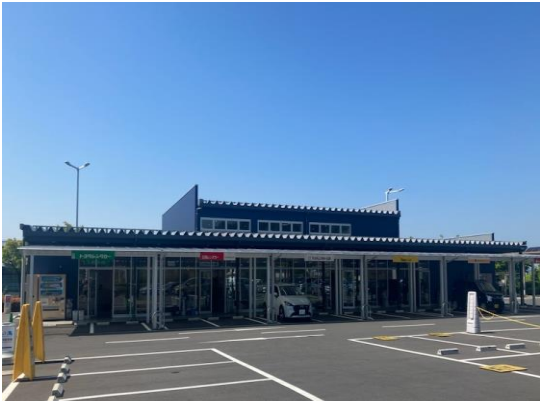
RENT-A-Car.Port建築工事
