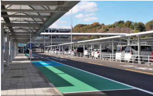
空港駐車場平面工事（ドロップオフレーン）
