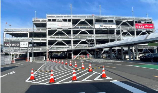
立体駐車場広告看板設置工事
