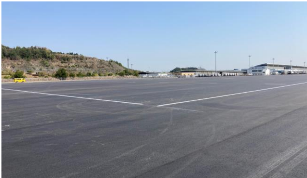
G7サミット関連仮設GSE置場整備
