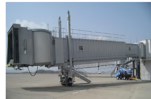
旅客搭乗橋（#6A）更新工事
