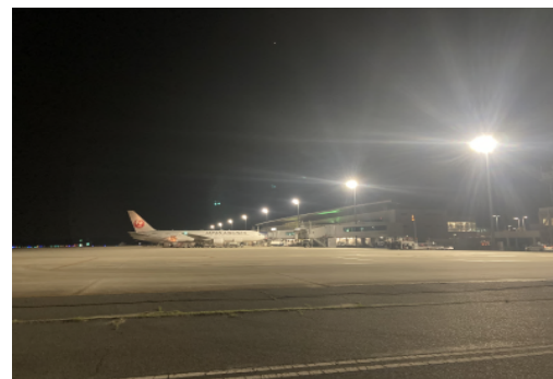
エプロン照明灯等LED化工事
