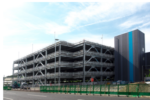
立体駐車場建設工事
